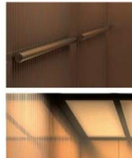
吊顶：玫瑰金发纹不锈钢框架，亚克力
